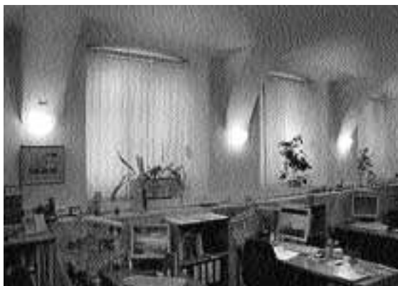
Своды первого этажа. Фотография. 2005 г.
