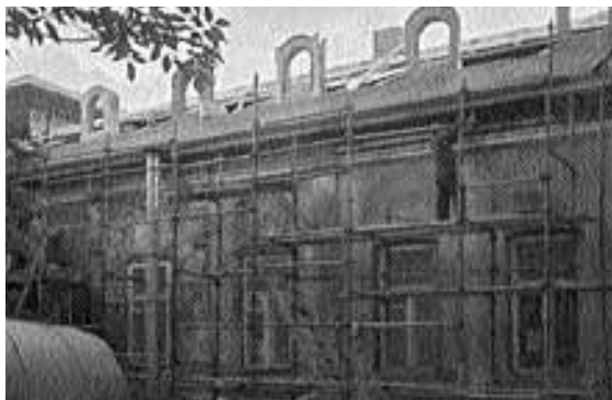
Фрагмент фасада. Август 1997 г.
