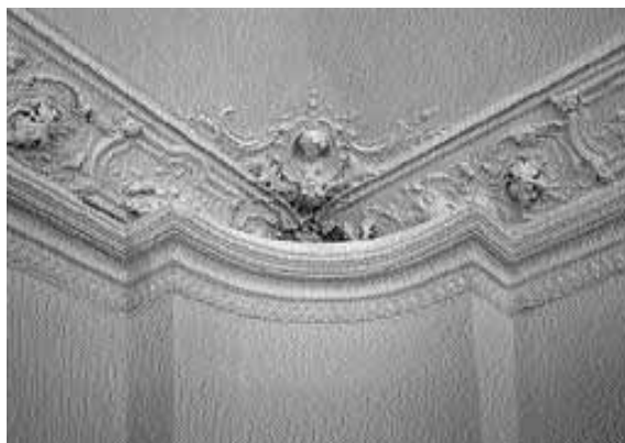
Лепной карниз гостиной. Фотография. 2005 г.
