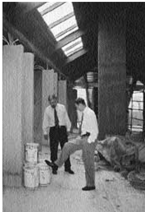
Мансарда. Отделка внутренних помещений. Август 1997 г.
