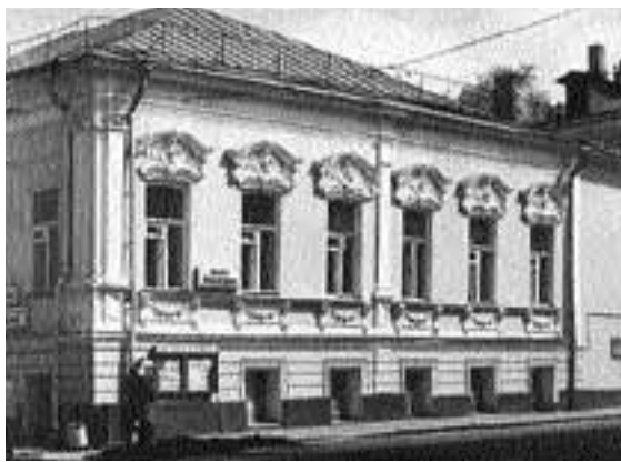
Вид дома со стороны Малого Харитоньевского переулка. Фотография А.А. Александрова. 1979 г.
